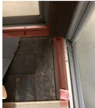
1列の雨戸のレールが窓の内側に残されている
