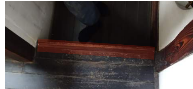
2階にも雨戸のレールが残されている
