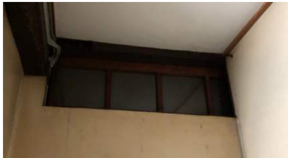
廊下に沿って続く窓が増築部分まで残されている
