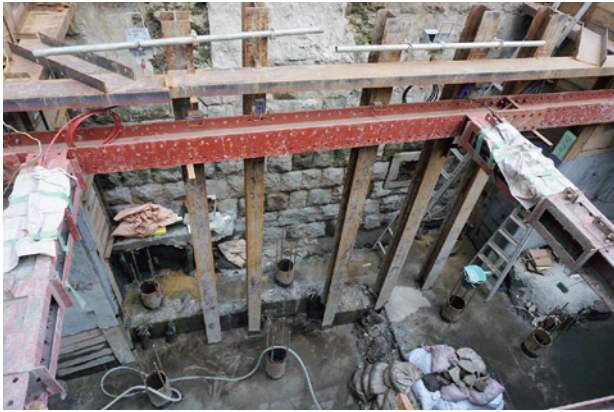
(画像1:中央区のマンション工事現場で発掘された新川堀の石積み護岸)
